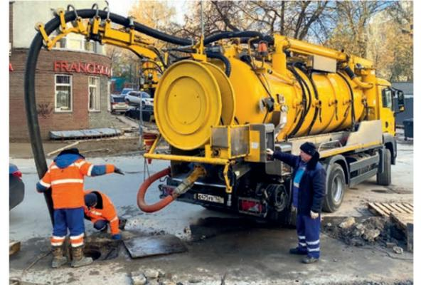
в промывке труб. Задача водителя не только доехать до места проведения работ, но и выполнить их. Он направляет оборудование согласно потребностям слесарей, которые, находясь в колодце, устраняют засор.
